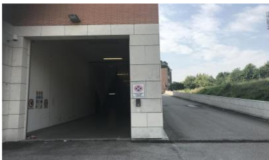
Portone di carico e rampa di accesso Via Cairoli 4/D
